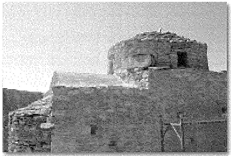
*Face nord, le jointoyage du mur est terminé, reste à faire le tambour de la coupole et l'abside ainsi que la couverture.*
