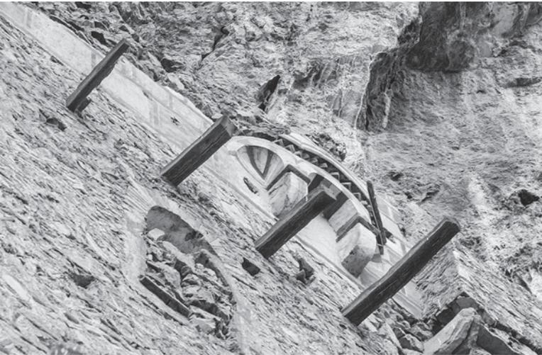
Fig. 4: L'abside saillante construite en léger encorbellement.
