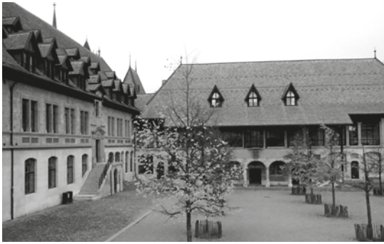
Fig.1: Vue des bâtiments du Collège, inaugurés en 1559 (bâtiment central, à droite) et 1561 (bâtiment sud, à gauche, remanié au XIX e siècle)
